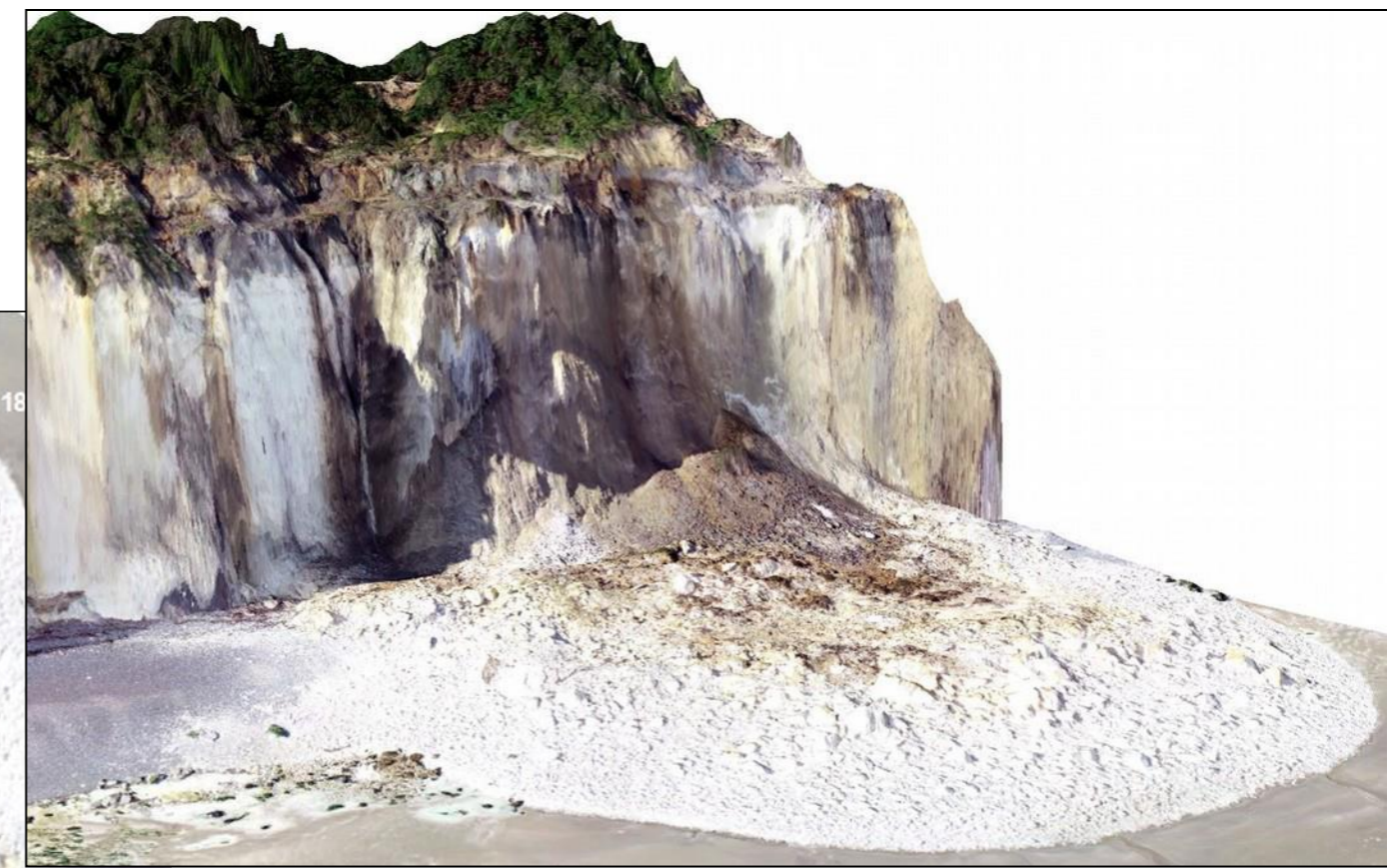
Modélisation 3D par acquisition drone
